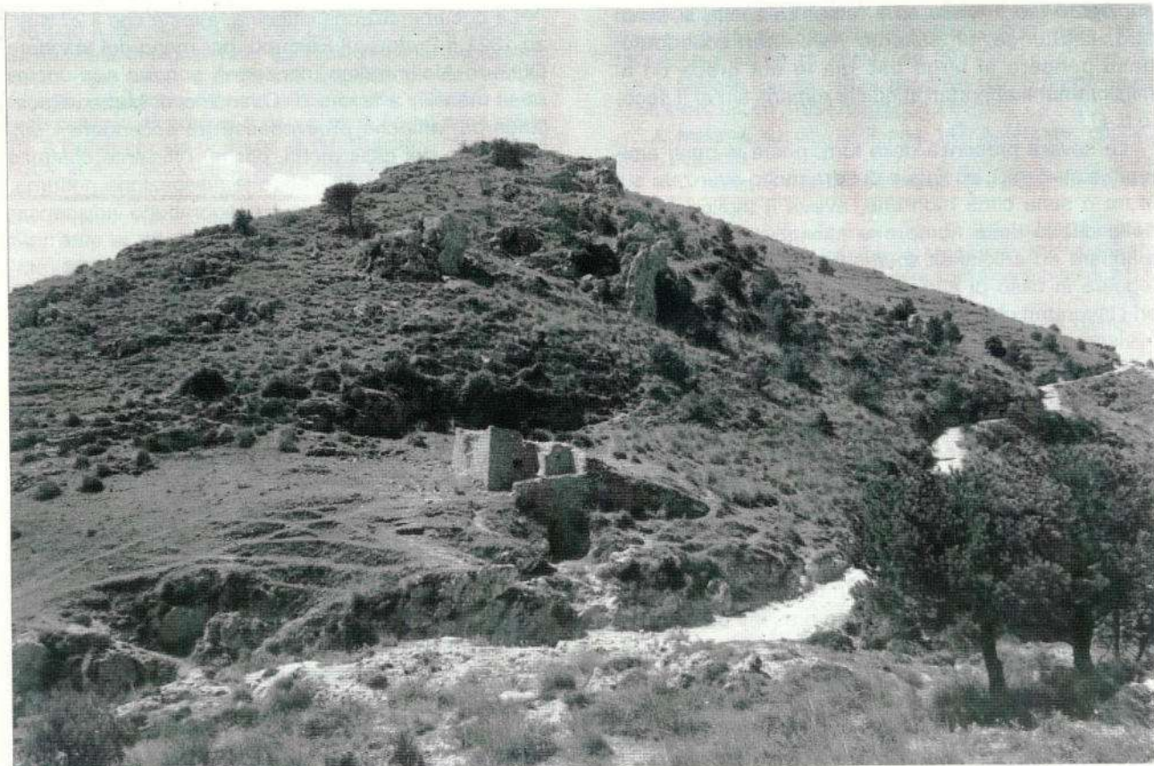
Fig. 1 - San Martino delle Scale (PA). Veduta generale del complesso chiesa e torre Sant'Anna e l'omonimo Passo.
