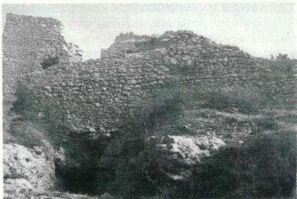
Fig. 8 - San Martino delle Scale (PA). La torre e l'ingresso alla chiesa ipogeica, visti da Nord.
