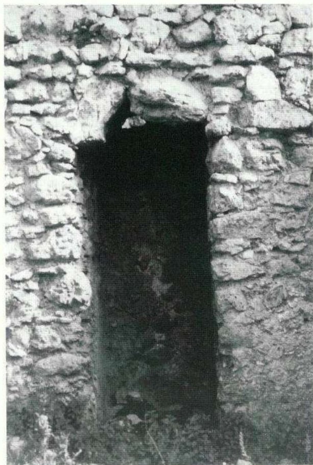
Fig. 9 - San Martino delle Scale (PA). Particolare interno della torre. Un vano murario è ricavato nel versante occidentale.
