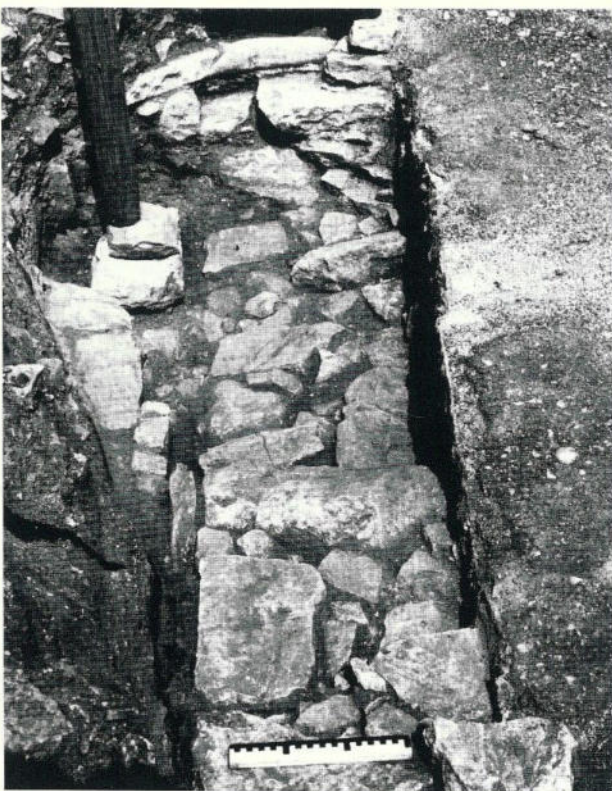
Fig. 33 - Le fondamenta del muro che separa il vano 22 dal cortile 23, da sud; in fondo il tubo di piombo, scolo della vasca da bagno del vano 21.
