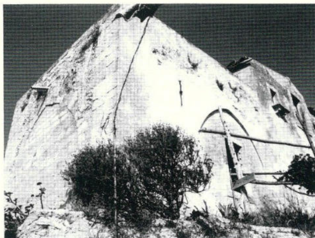
Fig. 3 - Veduta dell'edificio da sud.
