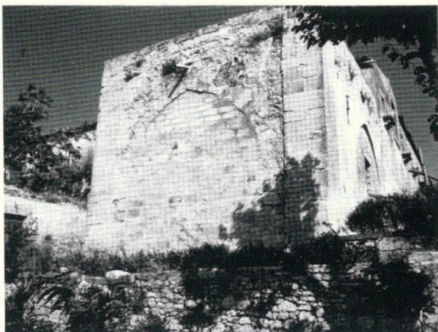
Fig. 2 - Prospetto nord-ovest dell'edificio.
