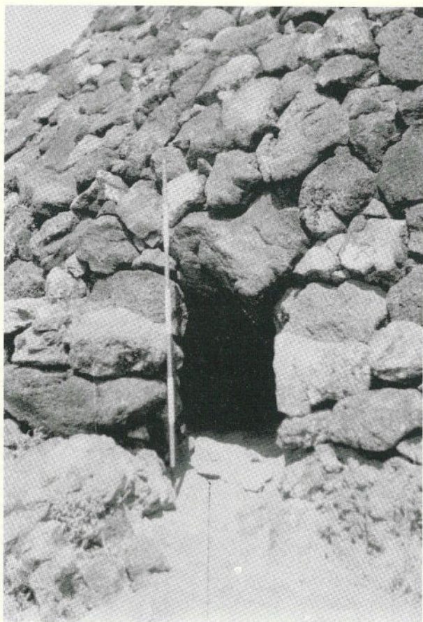
FIG. 12 - Sese n. 11 a nord-ovest del Sese Grande, tra la strada perimetrale di Pantelleria e il mare; si trova oggi inglobato in due muri di confine poderali.
