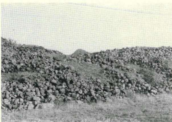
FIG. 6 - Il «Muro Alto» invaso da sterpaglia.
