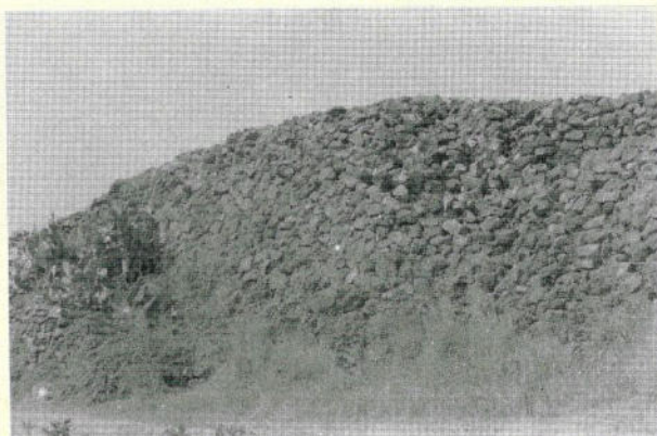
FIG. 9 - La parte esterna del muro; in questa foto si vede come era collocato il pietrame e la compattezza originaria del muro.
