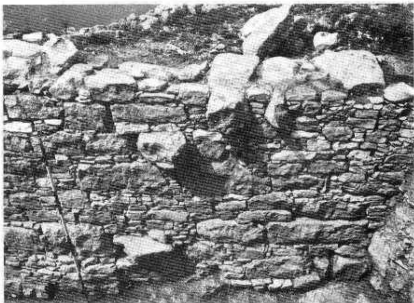
Fig. 9 — Il muro di sostegno del saggio 104
