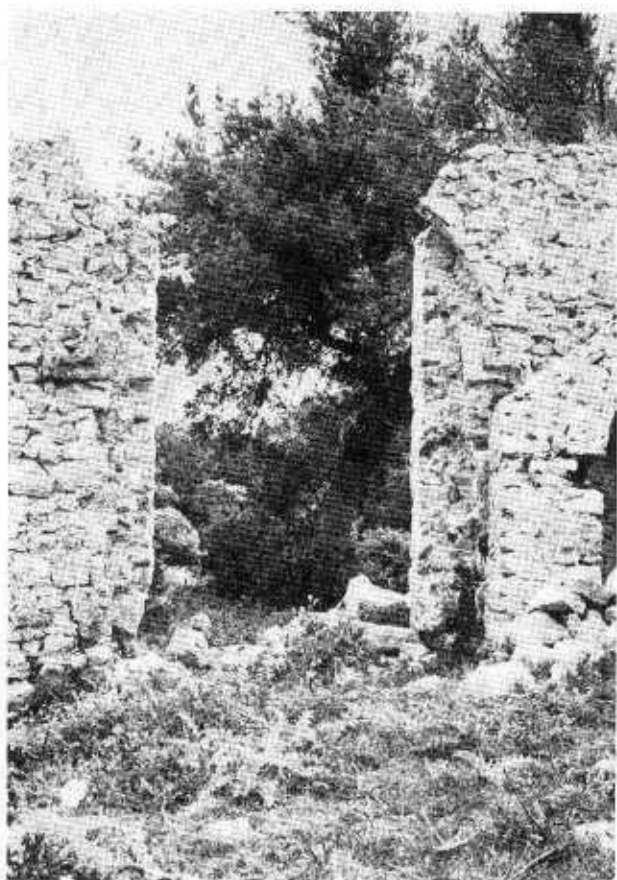
Fot. 10 — Particolare del vano d'ingresso. Sono visibili gli elementi d'imposta della ghiera dell'arco
