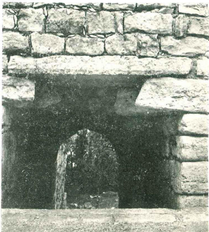
Fig. 10 - (sotto) - Postierla ad architrave rettilineo (parzialmente interrata)
